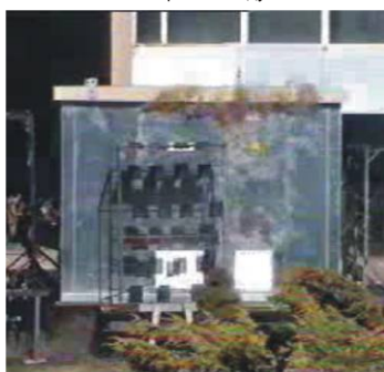
Испытание электрической дугой 20кА/1с
